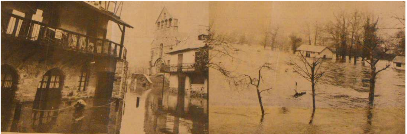
Fig. 13. Inondations à Beaulieu sur la Place de la Chapelle et au droit du Village vacance
